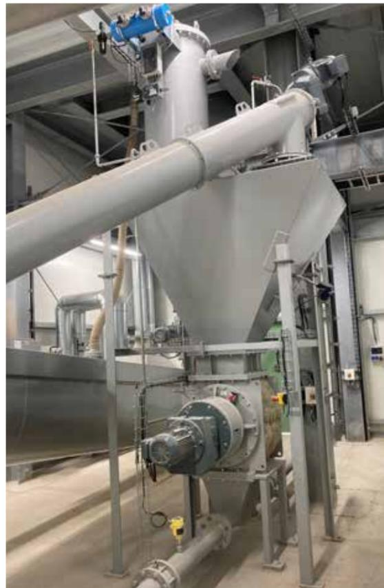
Die KREISEL Hochdruck-Zellenradschleusen sind auf dem neuesten Stand der Technik und aufgrund der Energiereduktion in der Motorleistung ideal als Austausch für Schneckenpumpen geeignet. Ihre hochverschleißfeste Auskleidung mit Keramikelementen reduziert den Verschleiß gegenüber herkömmlichen Zellenradschleusen um ein Vielfaches.
